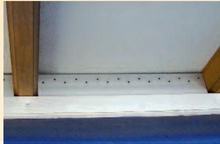
Alu-Lüftungsbleche zwischen den Sparren sorgen für die Durchlüftung des Daches
